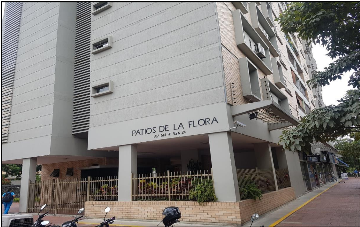
INTERVENTORIA EN OBRA CIVIL DE PINTURA E HIDROFUGADO EN FACHADAS DEL CONJUNTO RESIDENCIAL PATIOS DE LA FLORA.
