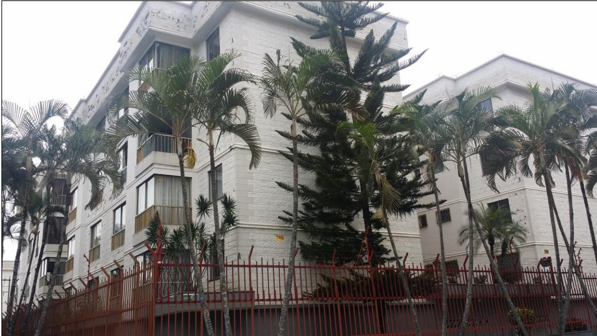
CONSULTORIA E INTERVENTORIA EN LA OBRA DE RESTAURACION DE FACHADAS Y ZONAS COMUNES PUENTE BLANCO III.
