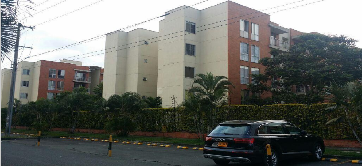
CONSULTORIA E INTERVENTORIA PINTURA FACHADAS Y ZONAS COMUNES CONJUNTO RESIDENCIAL PRADOS DE LA HACIENDA M14.
