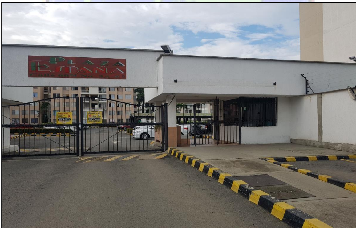
INTERVENTORIA EN OBRA CIVIL DE RESTAURACION Y PINTURA DE FACHADAS Y ZONAS COMUNES DEL CONJUNTO RESIDENCIAL PLAZA ESPAÑA.
