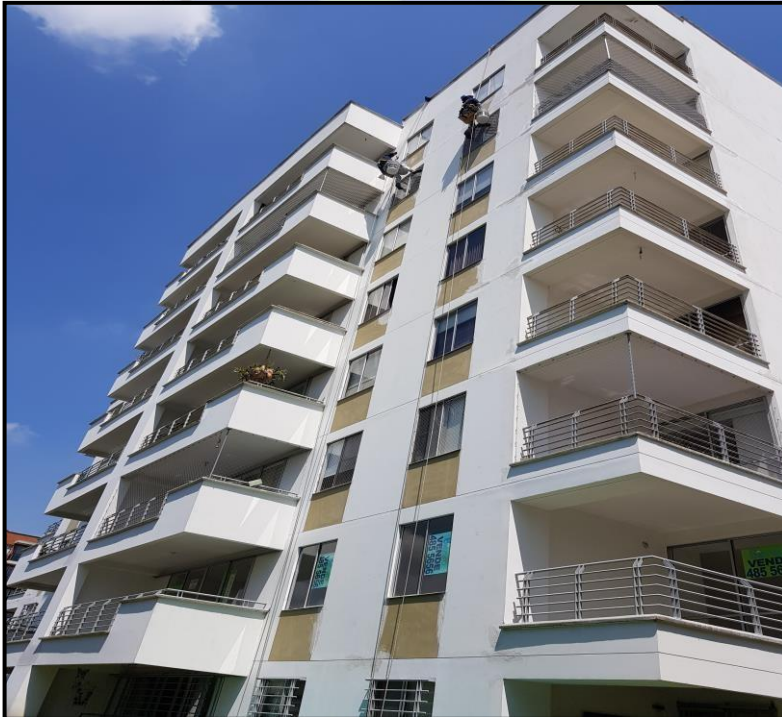
INTERVENTORIA EN OBRA CIVIL DE RESTAURACION Y PINTURA DE FACHADAS Y ZONAS COMUNES DEL CONJUNTO RESIDENCIAL BALCONES DEL LIMONAR III.
