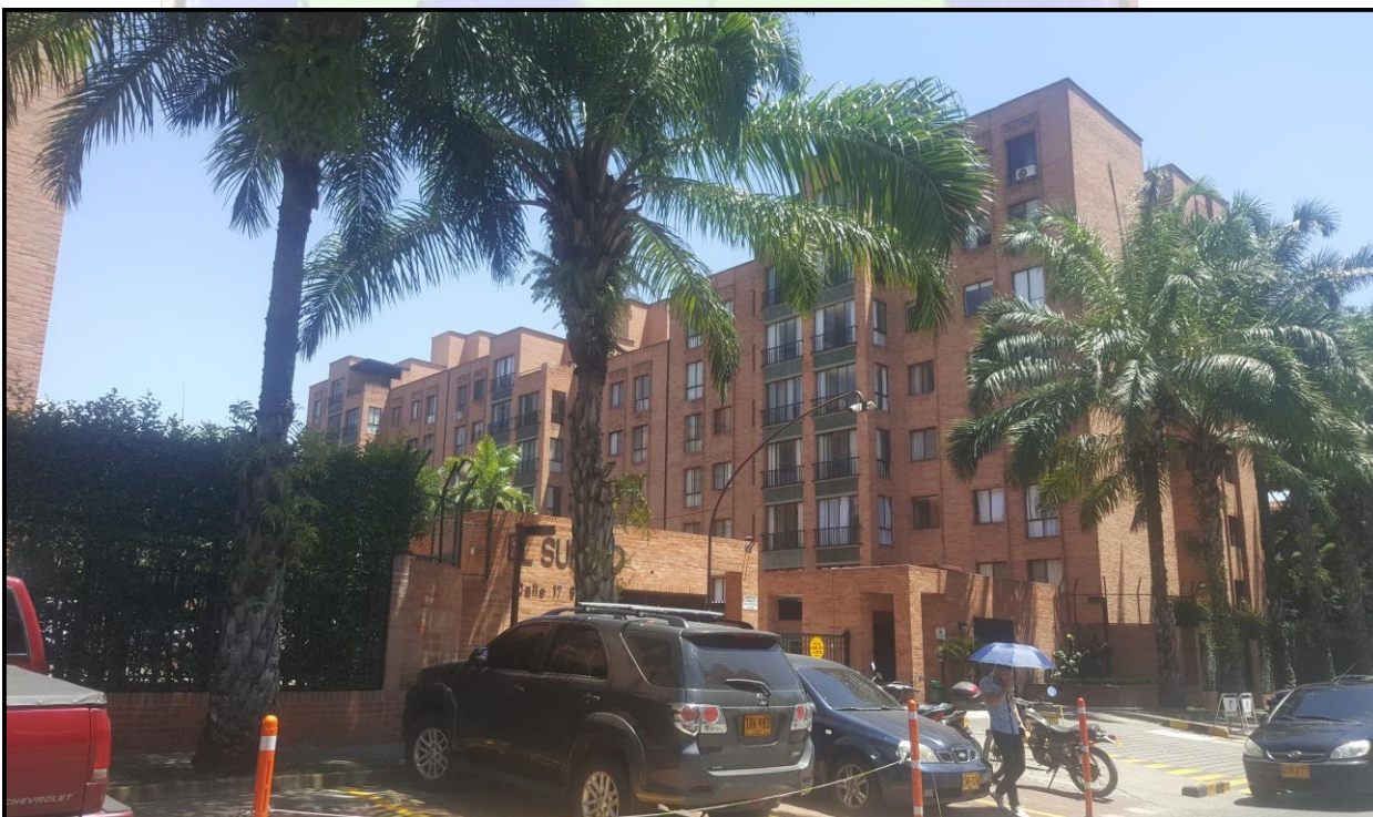
INTERVENTORIA EN OBRA CIVIL DE PINTURA E HIDROFUGADO EN FACHADAS DEL CONJUNTO RESIDENCIAL EL SURCO.
