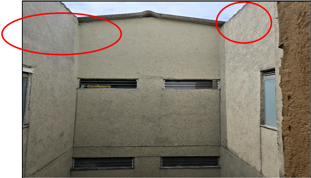
OBSÉRVESE EL DETERIORO DEL CONCRETO DE LOS MUROS DE CORONA DE FALTA DE PROTECCIÓN.
