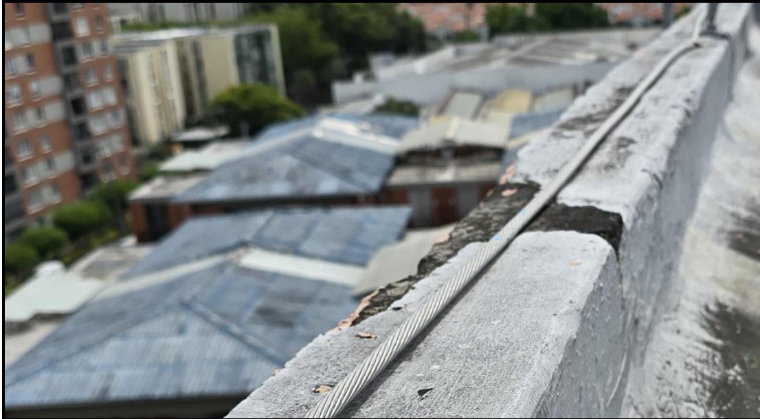
OBSÉRVESE EL DETERIORO DEL CONCRETO DE LOS MUROS DE CORONA DE FALTA DE PROTECCIÓN.
